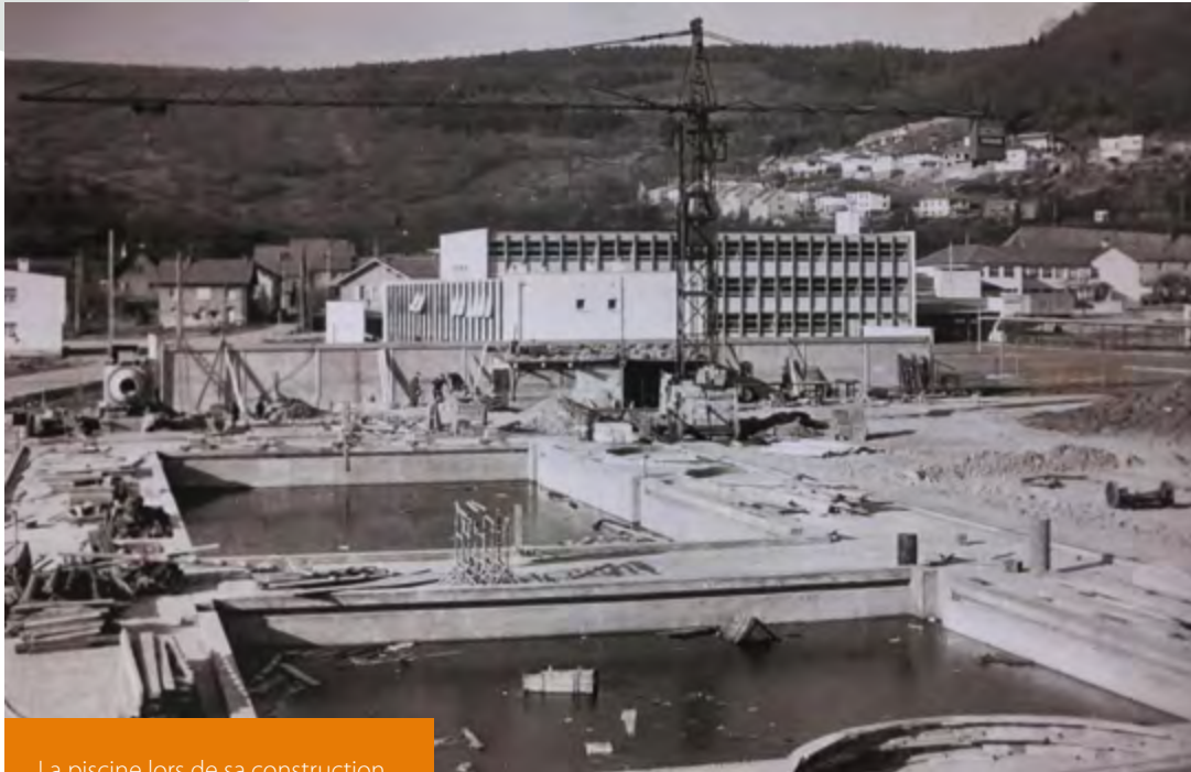
La piscine lors de sa construction
